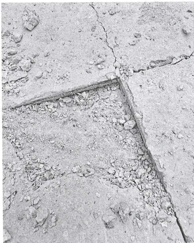
foto 01- Teste de arrancamento
